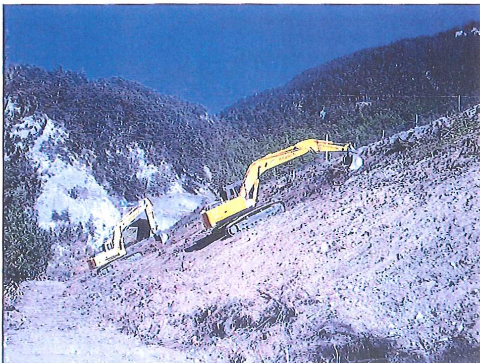
Photo 2: Après le déboisement, un débroussaillage est effectué - Galerie de sécurité du tunnel du Fréjus, juillet 2009.
