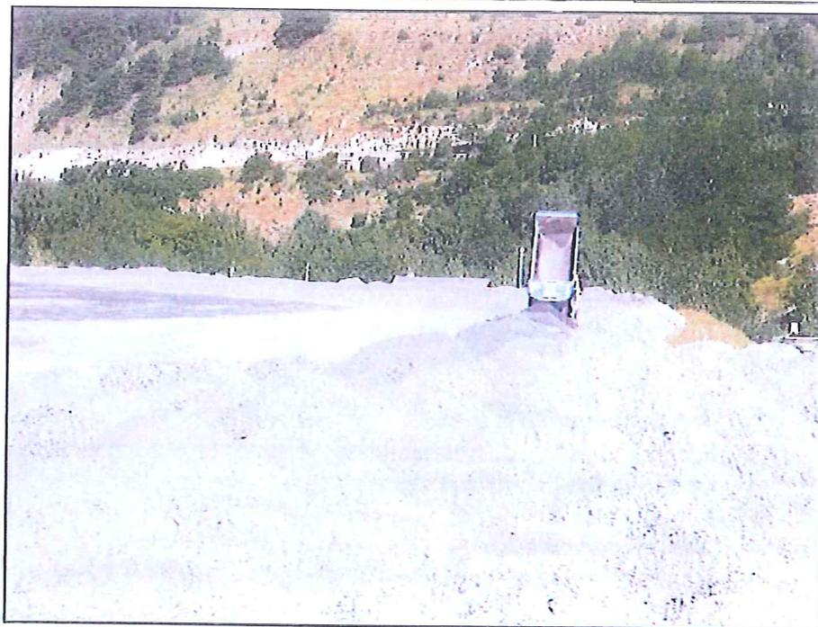
Photo 3: Mise en dépôt de marirage issu du creusement de la galerie de sécurité - Modane, 2013
